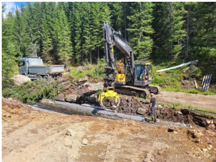
Nedlegging av halvbuerør ved Store Sinnera.
