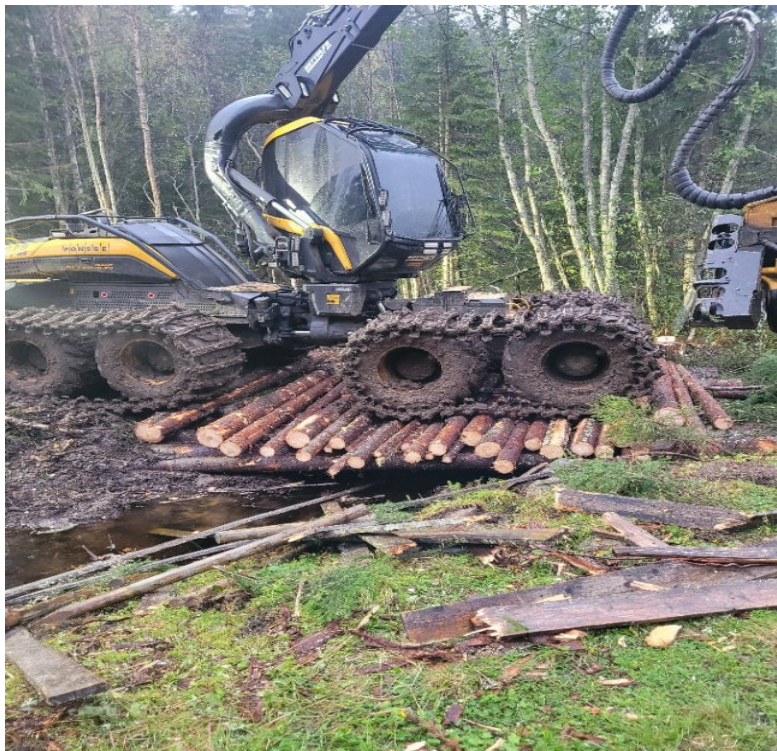
Bygging av bru over Syverdalsbekken
