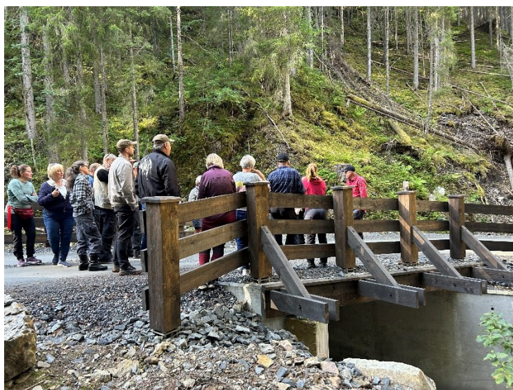
Bruksrettsbefaring av ny bru i Svenådalen
